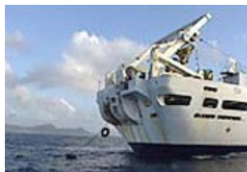
海底ケーブルの敷設作業
