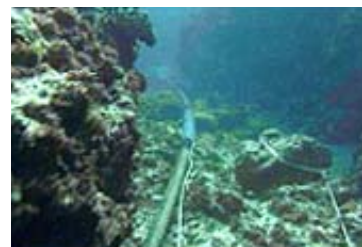
敷設された海底ケーブル
